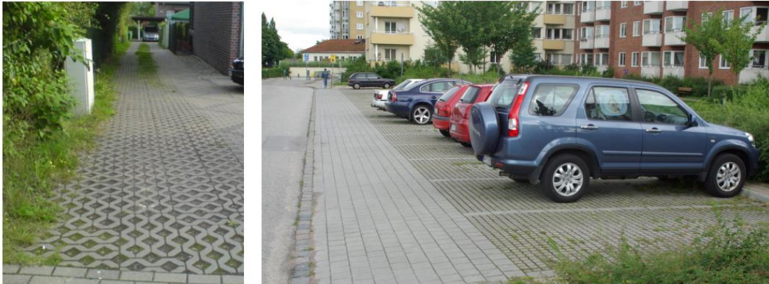
Figur 13. Exempel på gräsarmerad betong, en typ av genomsläpplig beläggning som är lämplig för parkeringsplatser. 22
