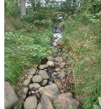
Figur 26. Stensatt utloppsdikey uppströms stig
