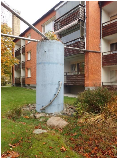
Figur 49. Exempel på cistern ovan mark, kv Inspektoren, Kalmar. VOS teknik AB
