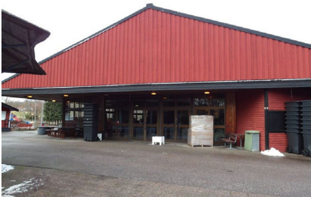
Glashuset mot sydväst. Till höger i bild syns en av de båda tillbyggda serveringsdelarna.
