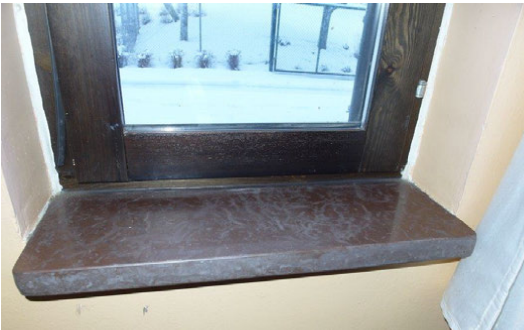
Mindre fönster av betsat trä och fönsterbänk av kalksten. i en av logerna.
