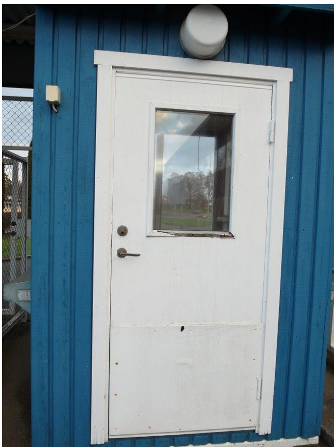
Dörr in till en av entréerna, mot väster.
