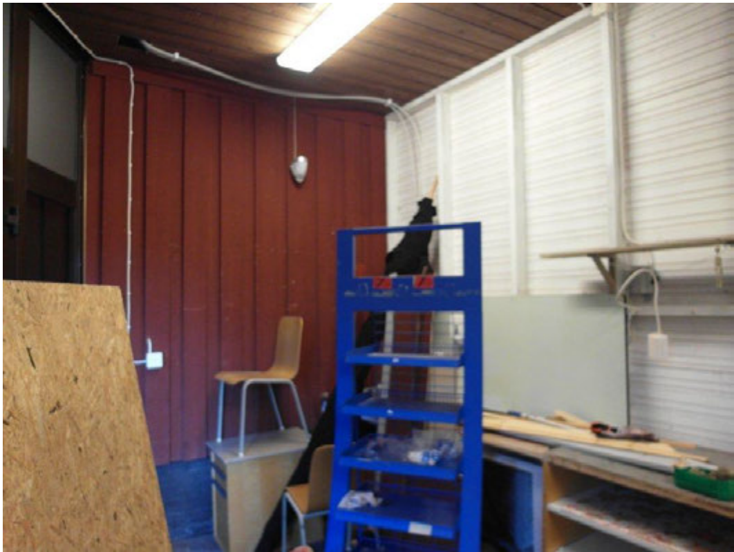
Tidigare yttervägg i en av de båda serveringstillbyggnaderna.
