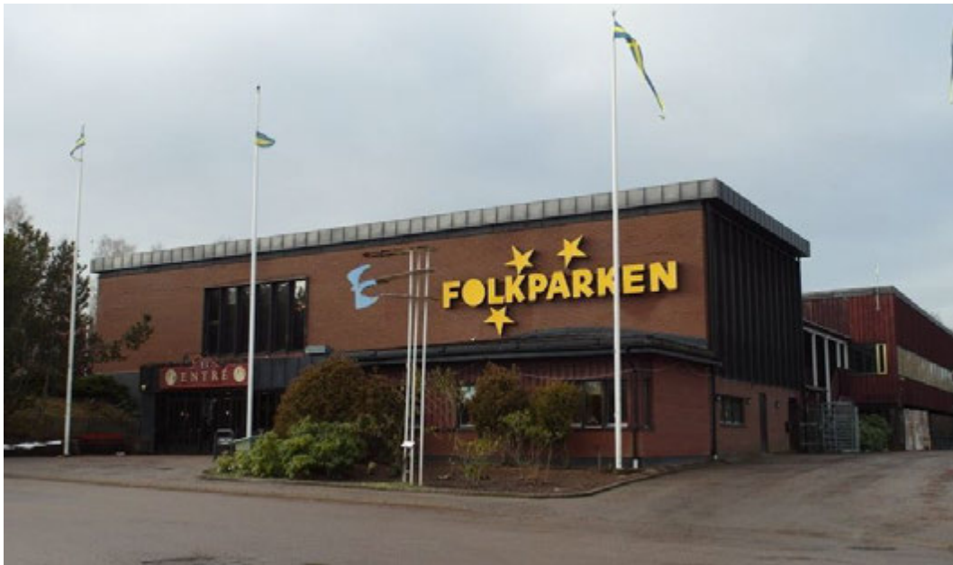
Östra entrén med tillbyggnaden från 1997.
