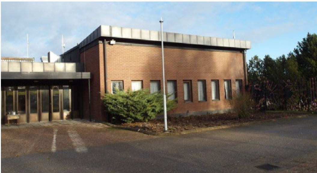
Södra fasaden, fönster till klubbrummen.
