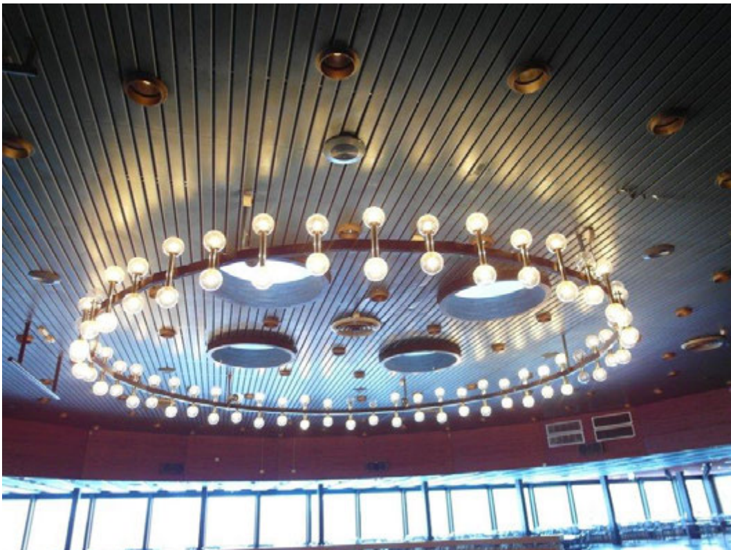
Taket över dansgolvet med plåtpanel och armaturen.
