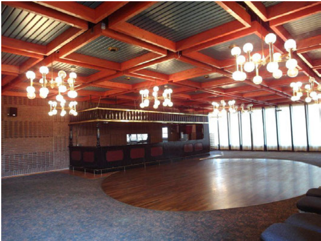
Galaxen med en glasvägg mot norr. Väggarna är av mönstermurat tegel.
