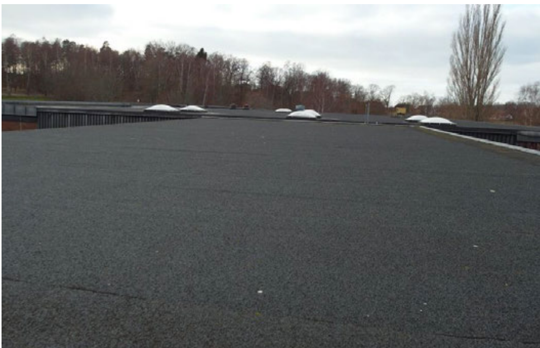
Takfall som är belagt med tjärpapp.
