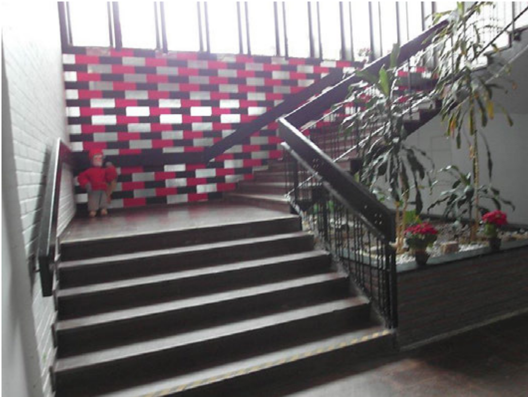
Trappan till övervåningen med växtplantering. Yttervägg med klistrad tapet. 136.
