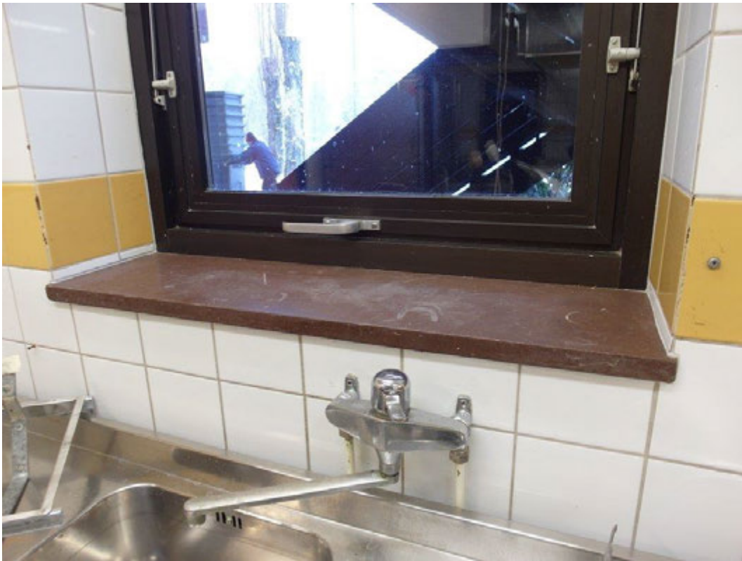
Köket, ut mot norr och mindre enluftsfönster med fönsterbänkar av röd kalksten.
