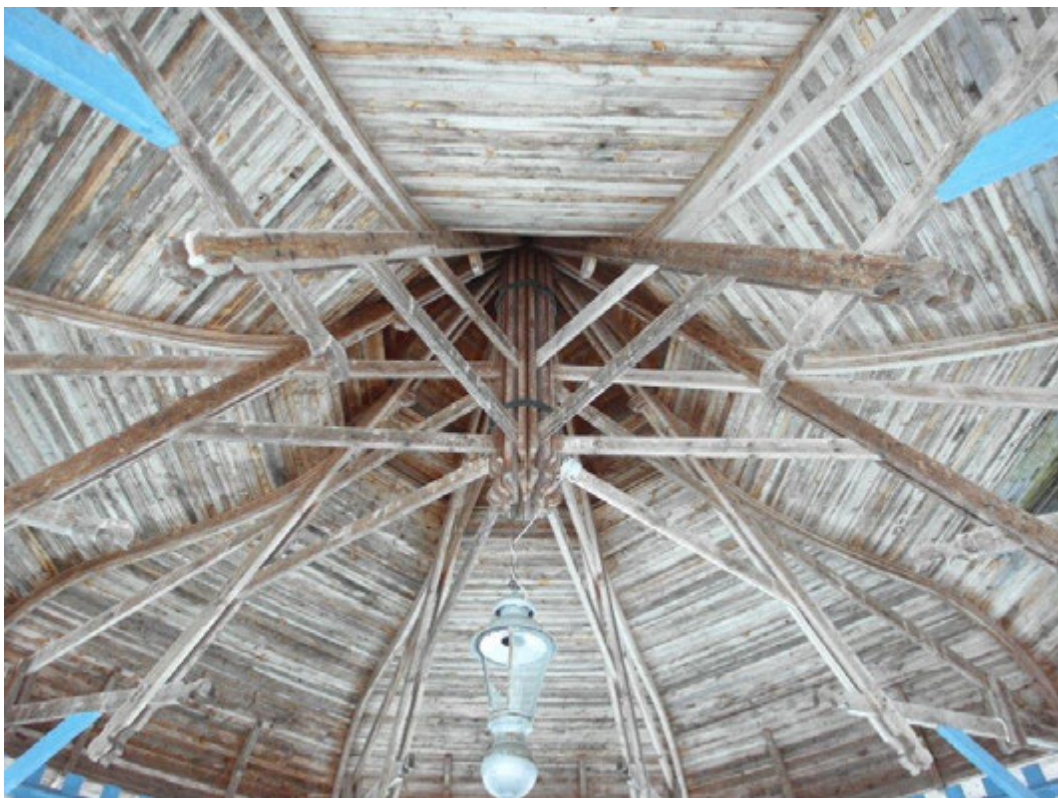
Turkiska tårten med den synliga takkonstruktionen där armaturen från Gamla Folkets park hänger.
