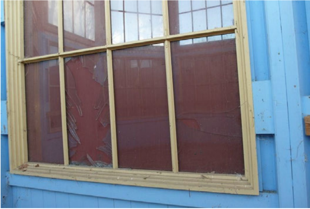
Fönsterbåge med spröjsade glasrutor.
