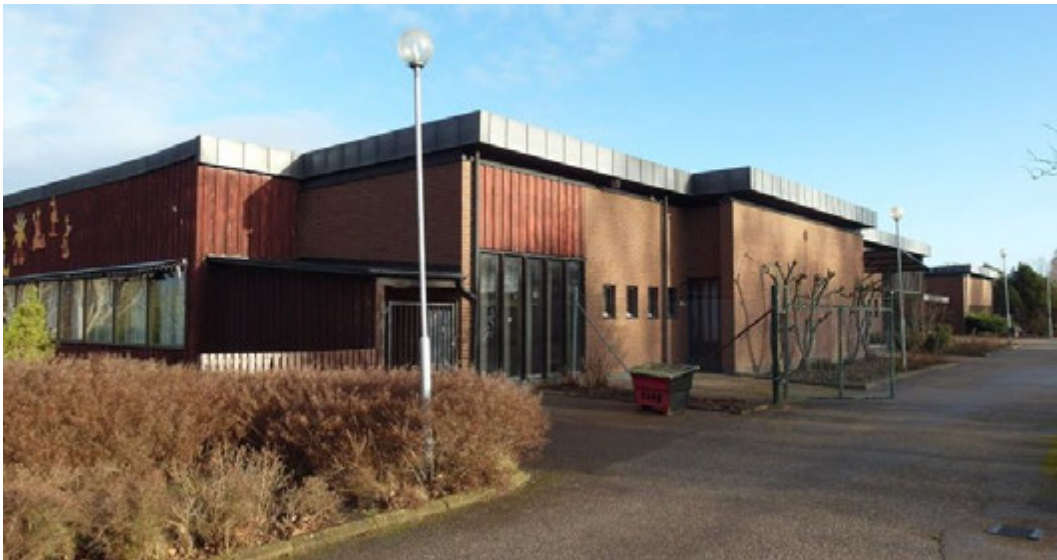
Fasaden, sydvästra hörnet.
