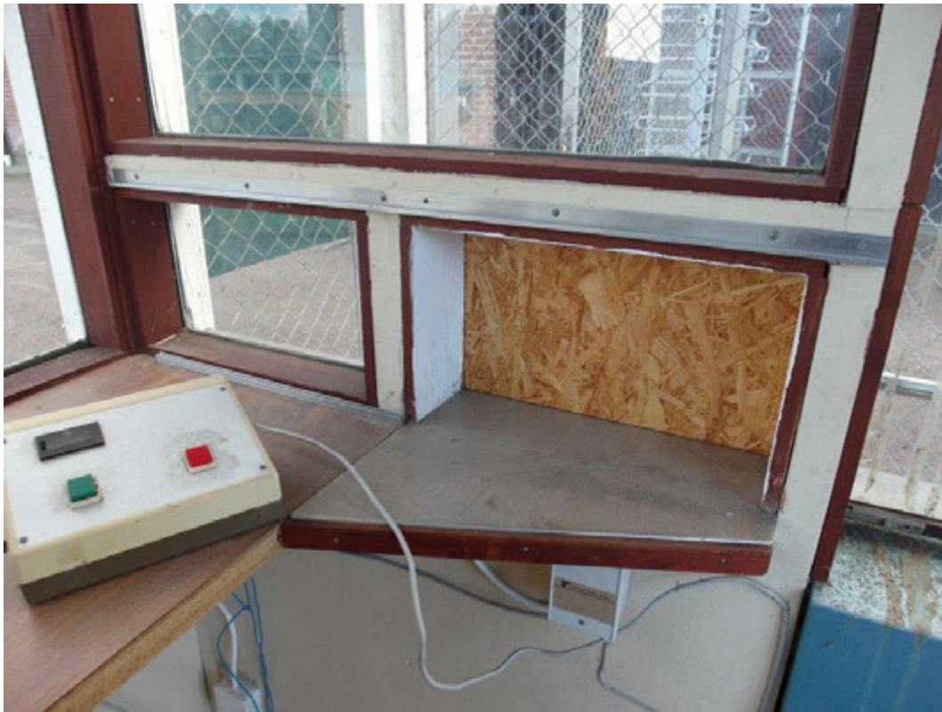
Detalj kassa med öppningsreglage för spärr.
