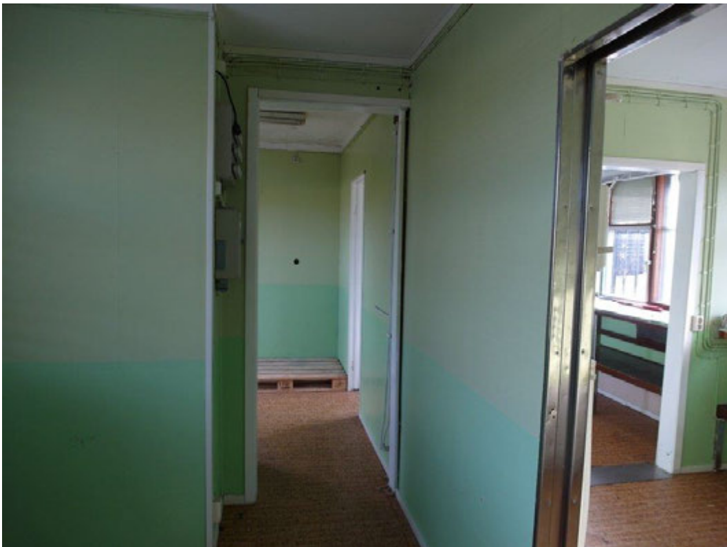
Rumsindelning där väggarna är klädda med målad masonit.
