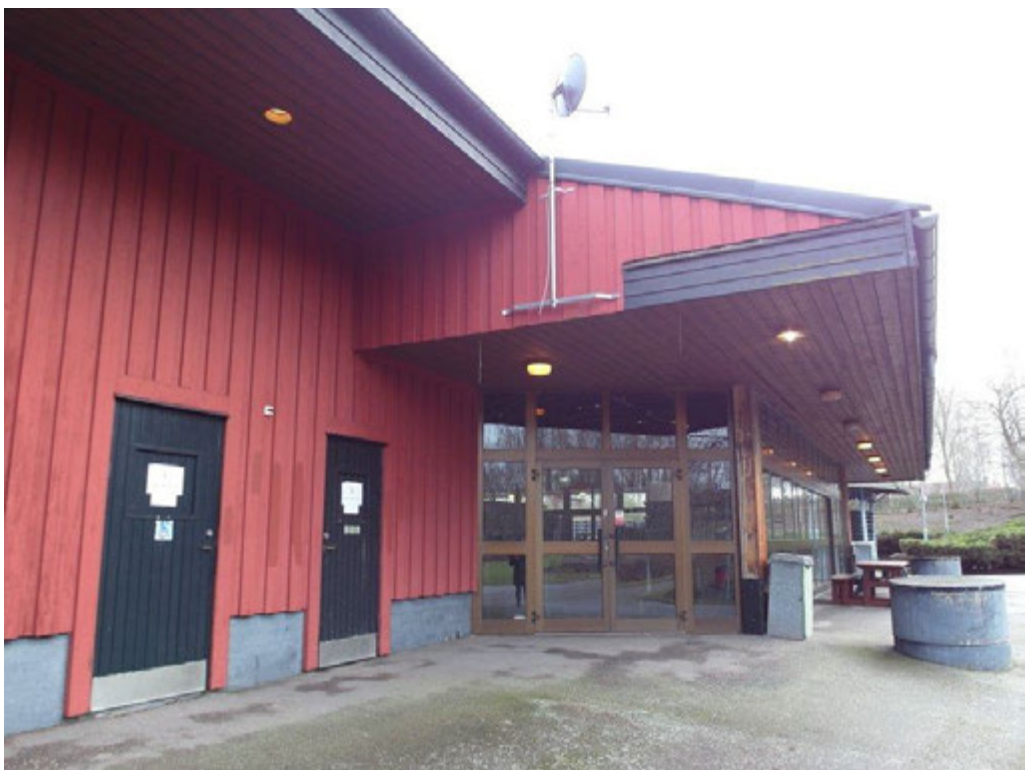
Glashuset har en ett kraftigt taköverhäng som fungerade som regnskydd, mot norr.
