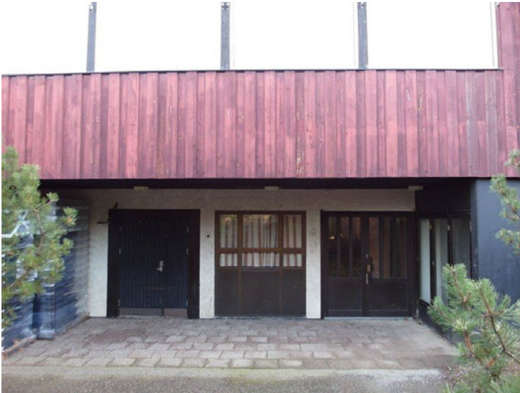
Västra entrén, vänstra dörren är utbytt.
