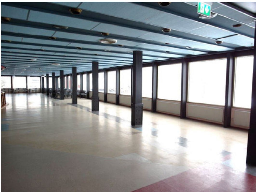
Utrymme norr om dansgolvet med bärande stolpar. 203.
