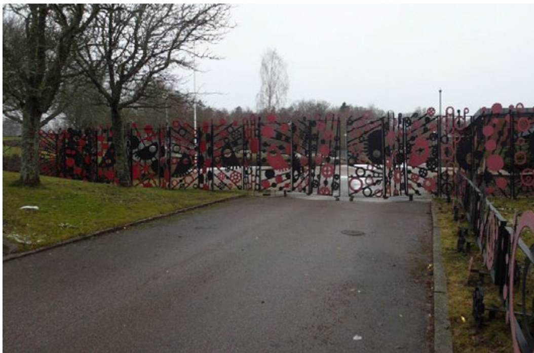
Grindar och staket vid södra entrén.
