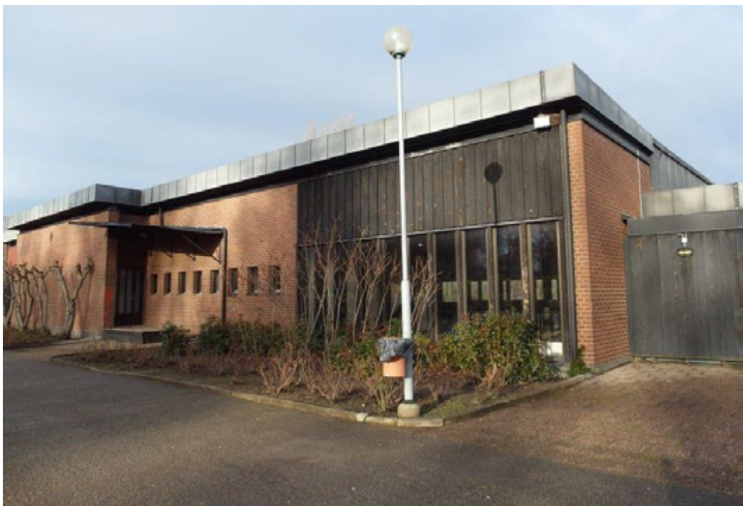
Södra fasaden, ljusinsläpp i stora trapphuset.
